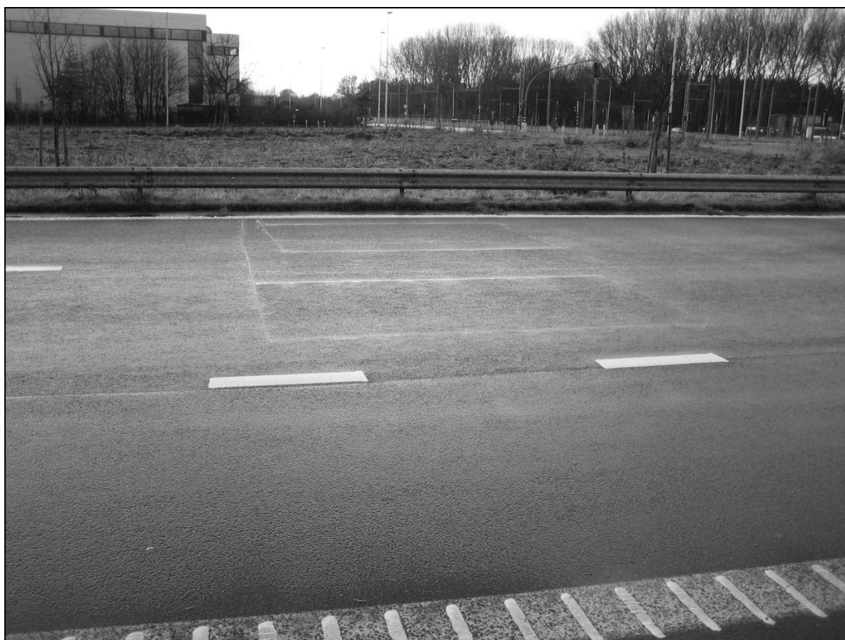
Figuur 12: Een voorbeeld van inductieve lussen ingebed in het wegdek [Mae06].
